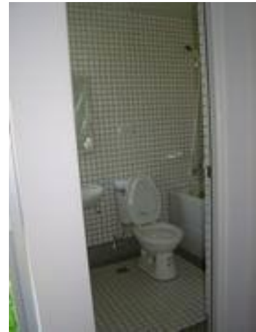
主臥室衛生間
